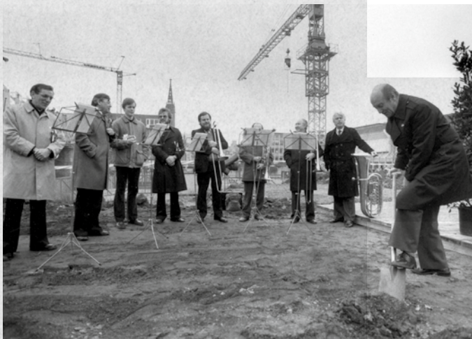
Erster Spatenstich für das Gebäude Pfälzische Philharmonie, Hans-Klüber-Platz am 11.01.1983
