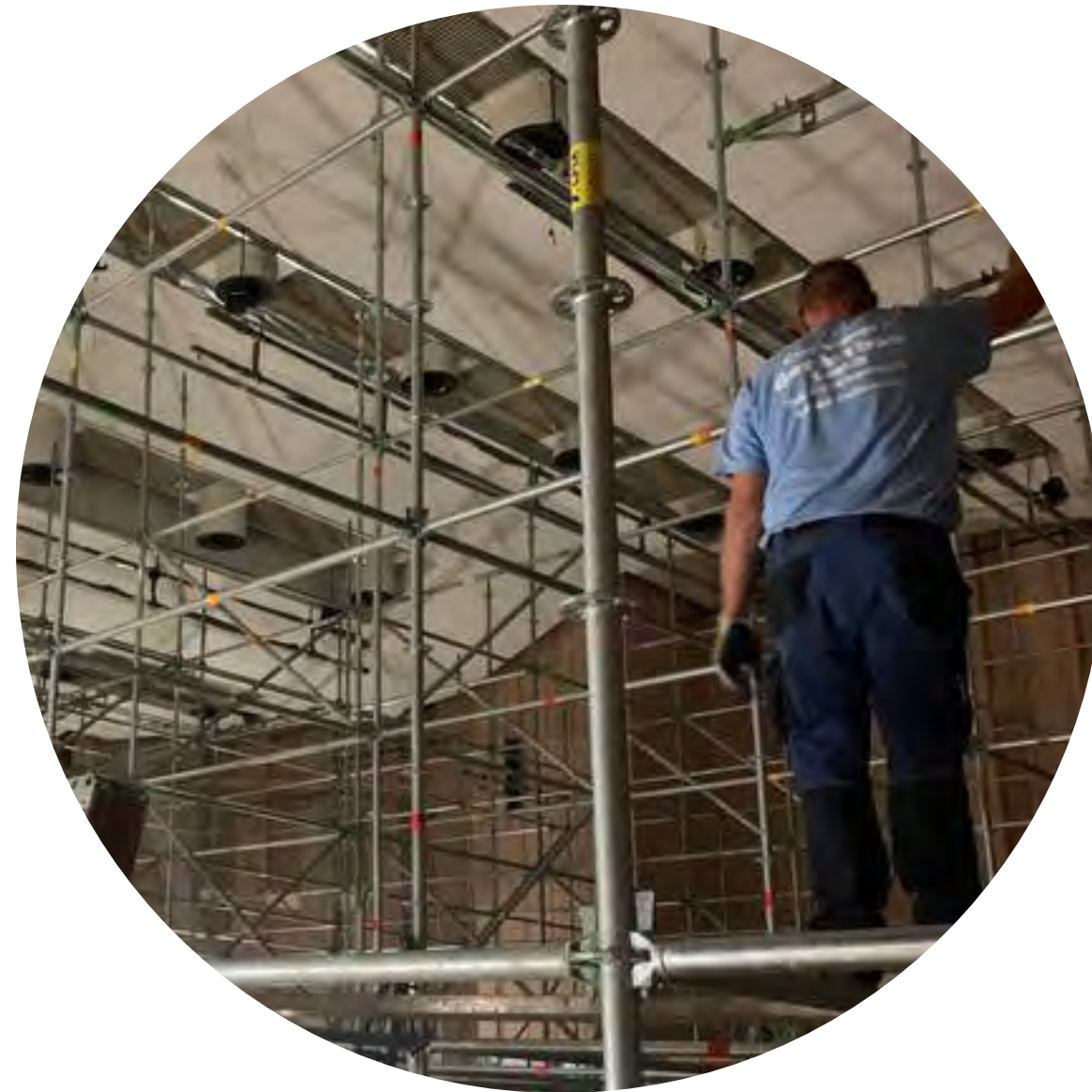
Umbau des Probesaals
